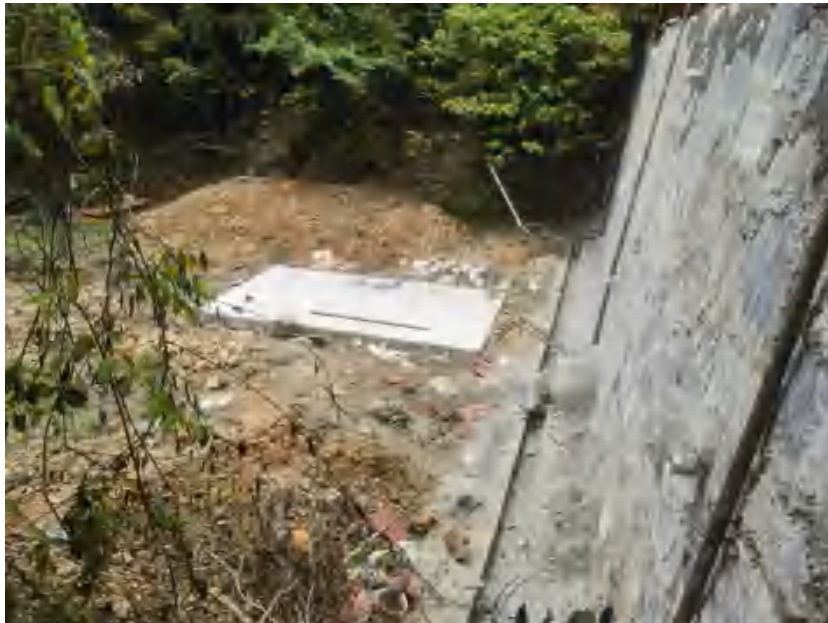
淋溶水池及挡土墙施工期照片（挡土墙含泄水孔）
